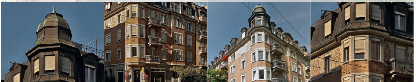
ZÜRICH | ZH Zentralstrasse 72
