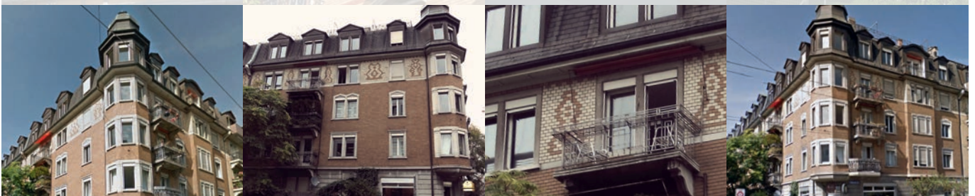
ZÜRICH | ZH Zentralstrasse 72
