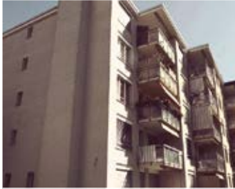
MURI | AG Klosterfeldstrasse 7-21
