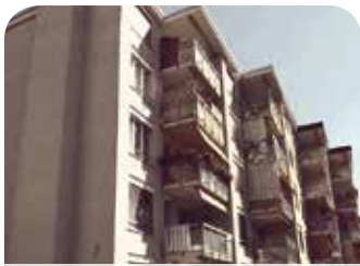
MURI | AG Klosterfeldstrasse 7-21
