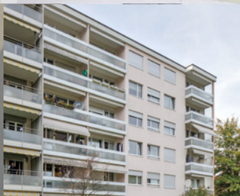
GLATTBRUGG | ZH Talackerstrasse 53b
