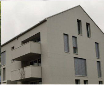
KOBLENZ | AG Landstrasse 44/46
