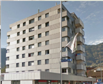
GOLDAU | SZ Parkstrasse 26/28
