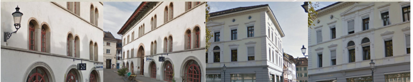
WINTERTHUR | ZH Tösstalstrasse 7/7a, Neustadtgasse 1a
