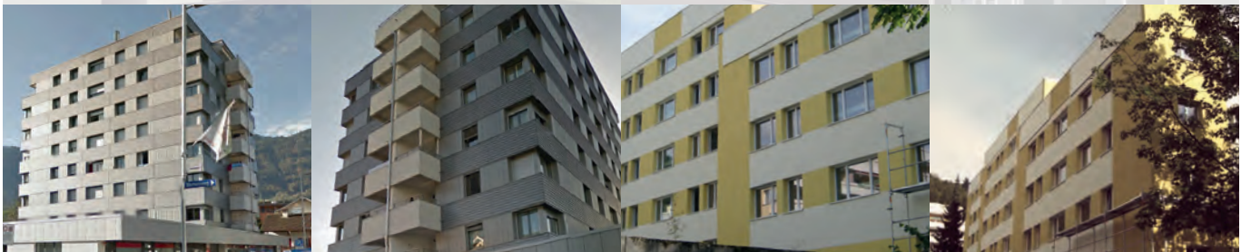
GOLDAU | SZ Parkstrasse 26/28
