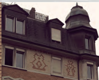
ZÜRICH | ZH Zentralstrasse 72
