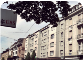
BASEL | BS Güterstrasse 199-205
